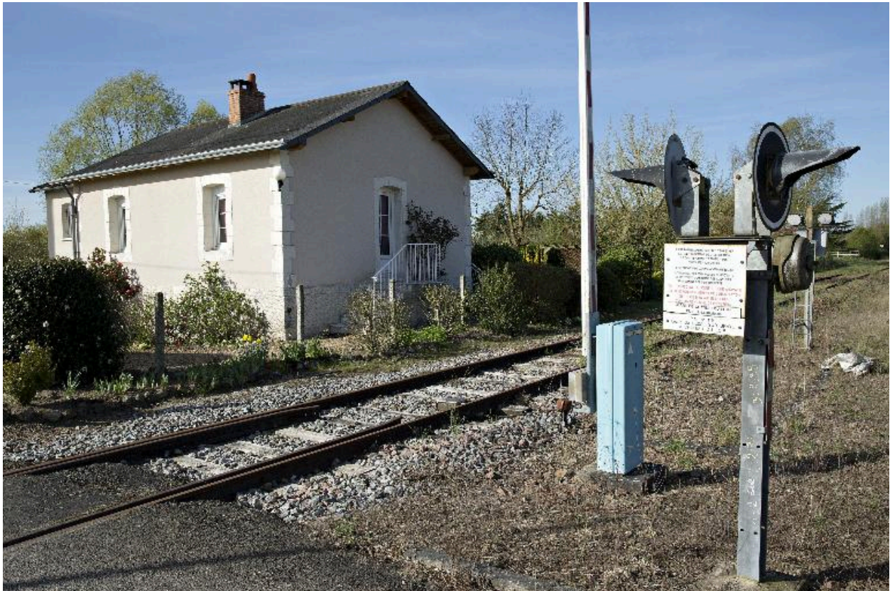
Ruillé-sur-Loir, la Varenne : maison de garde-barrière du PN 119.
