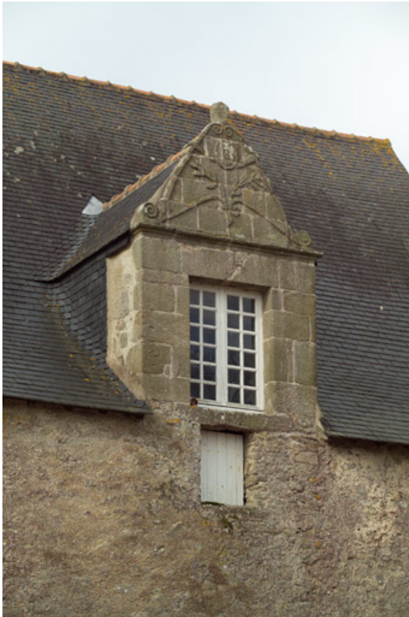
Lucarne à droite sur l'élévation droite des anciennes écuries.
