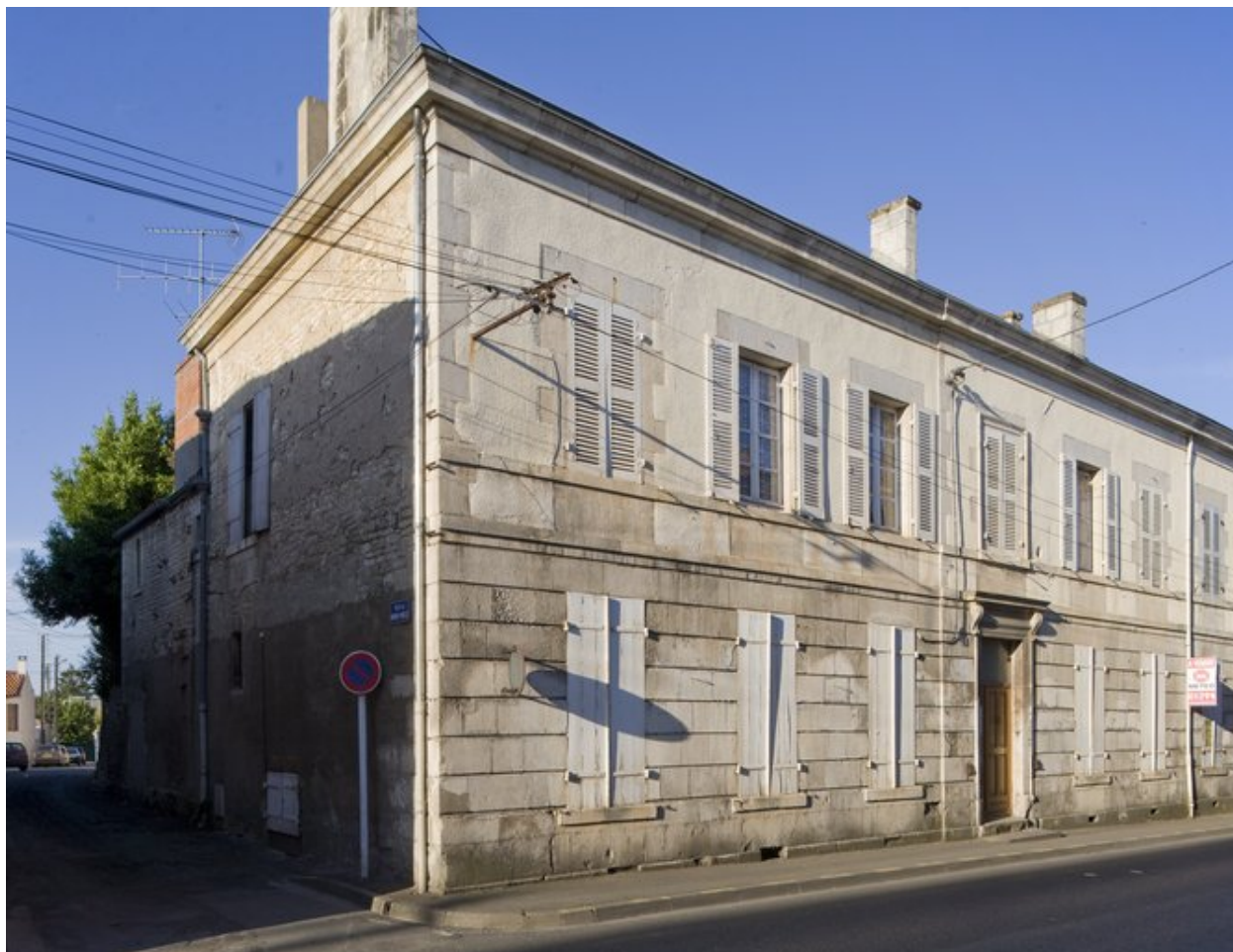
Façade sur rue du n° 6.
