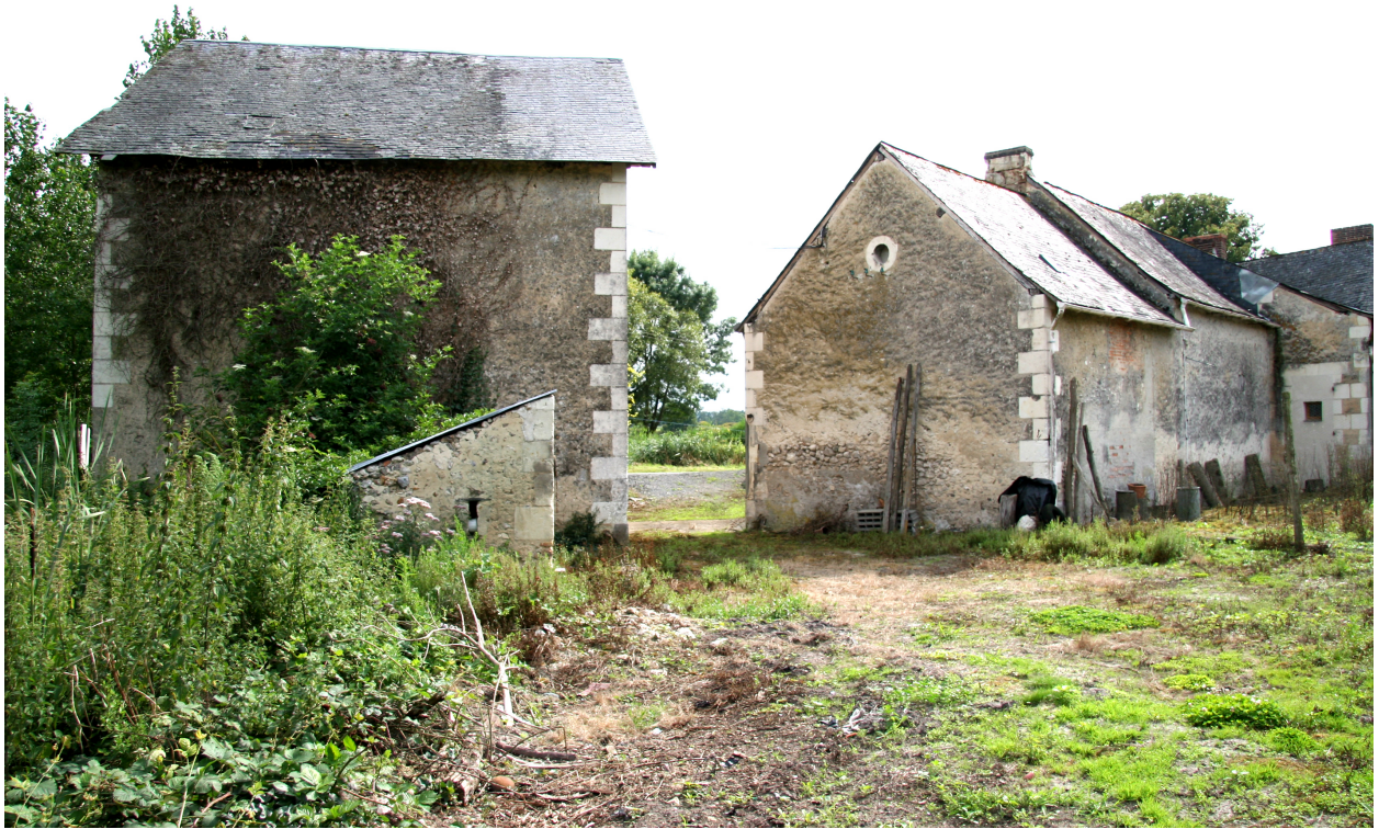
Le moulin et la maison : façades postérieures prises en aval.
