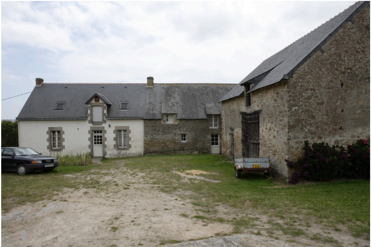
Métairie. Vue d'ensemble depuis le nord.
