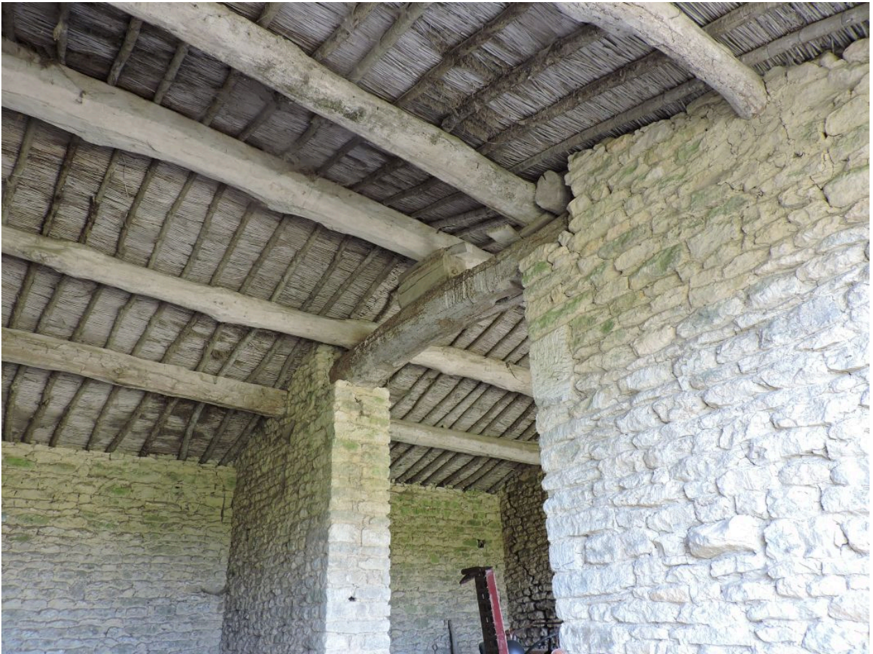
Toit en roseau du hangar en pierre.
