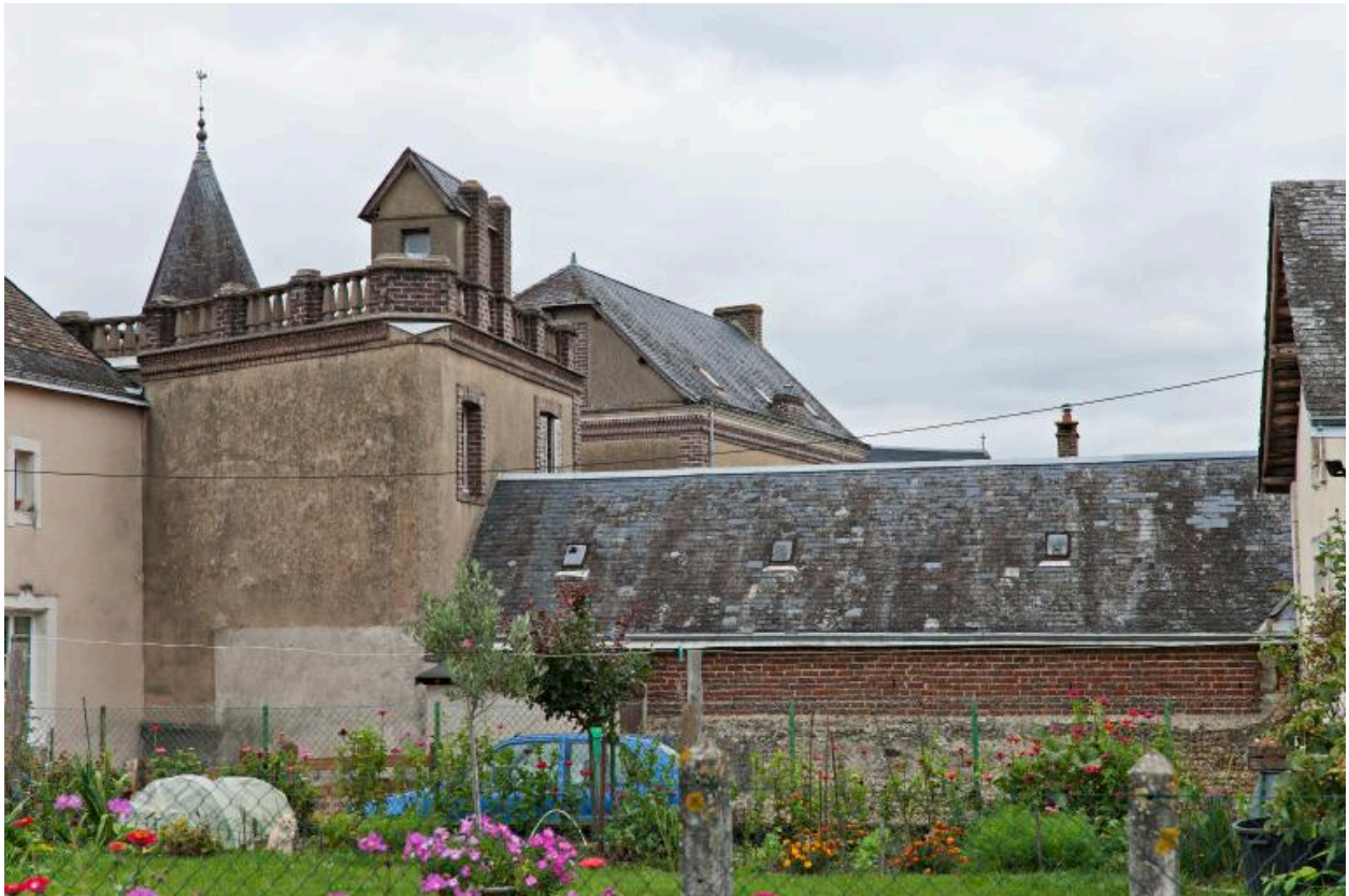
Vue d'ensemble prise depuis le sud-est.
