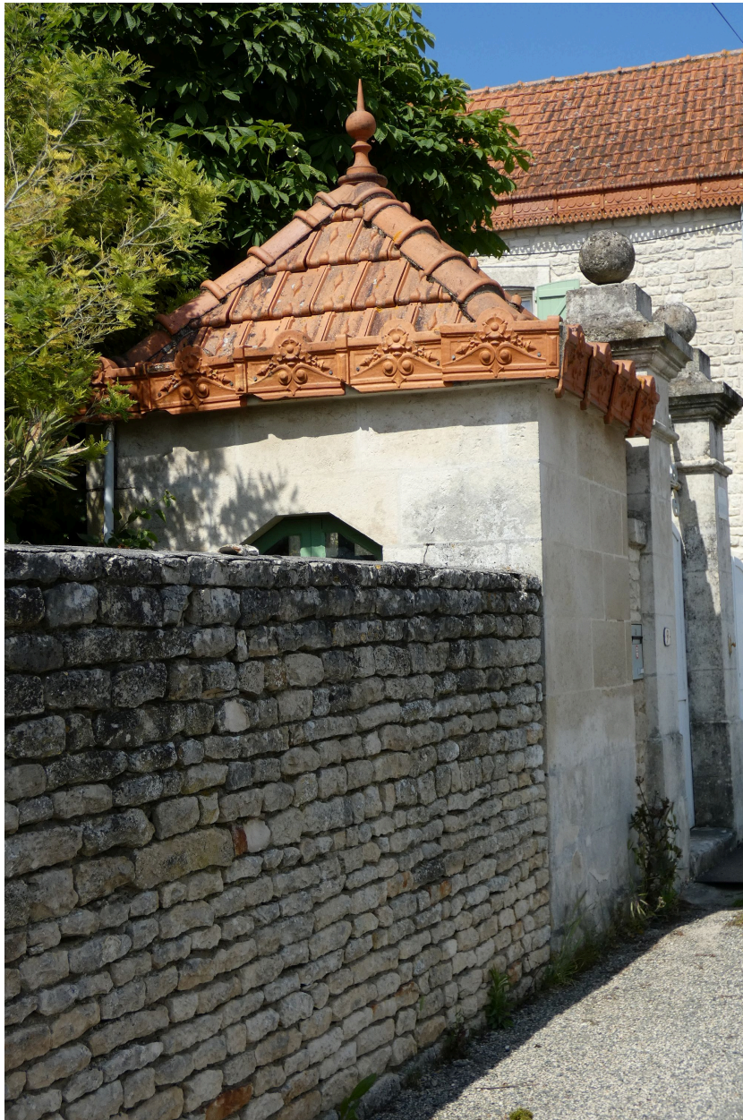
Le petit pavillon en bordure de voie, vu depuis le sud.
