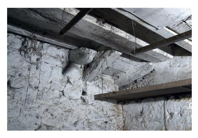
Intérieur du corps nord, rez-de-chaussée, cave est : détail de la poutre longitudinale et des corbeaux de la cloison est.
