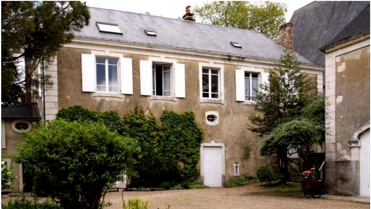
Logis : façade ouest avec entrée principale.
