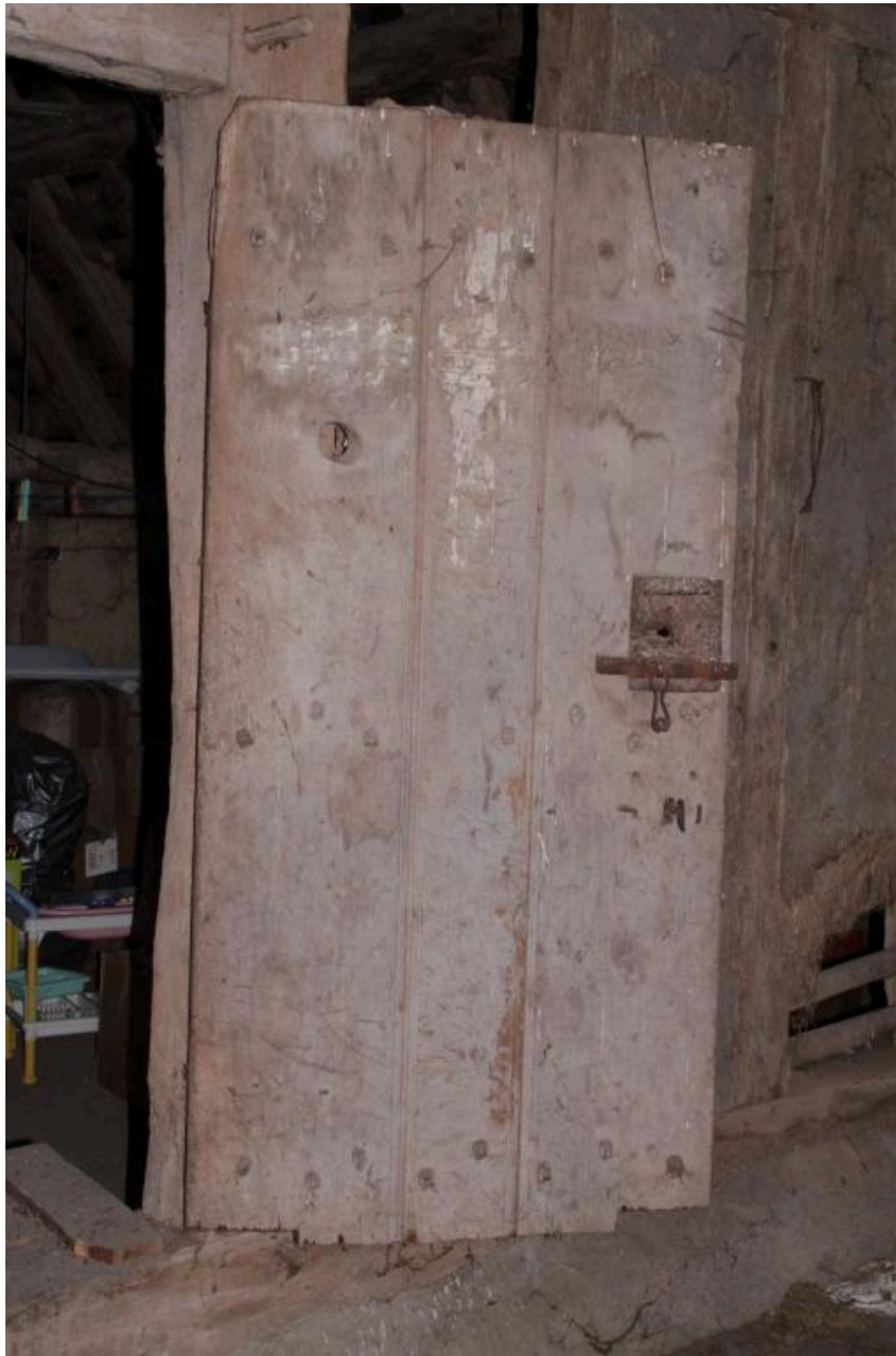
Cloison du comble : menuiserie de porte.
