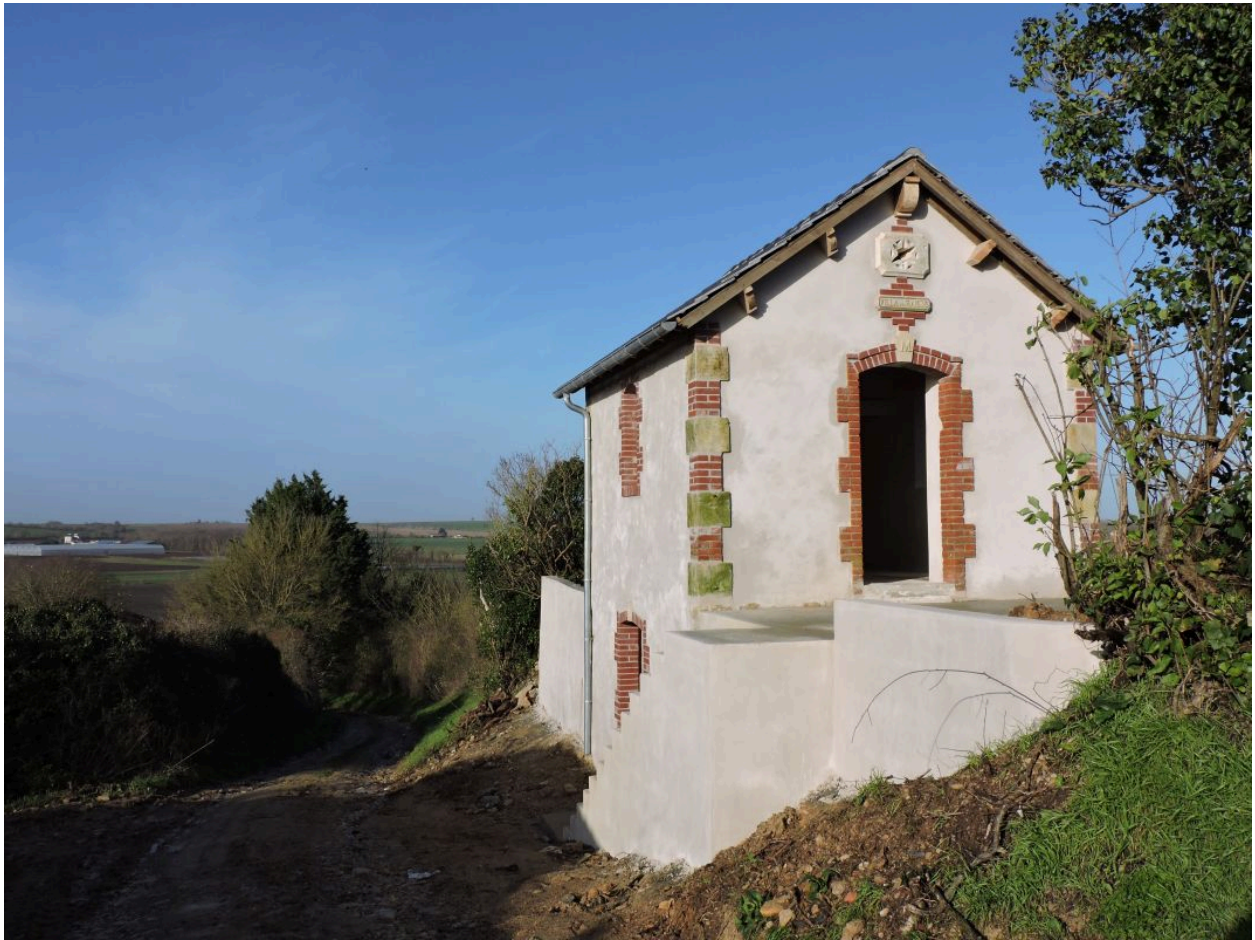
Le belvédère vu depuis l'est après restauration, décembre 2019.
