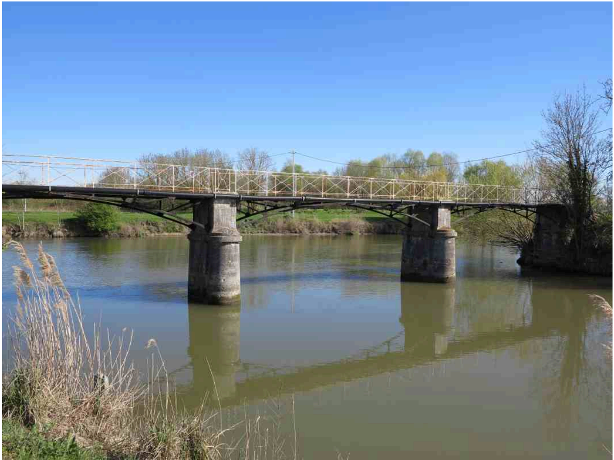
La passerelle vue depuis l'amont, au sud.
