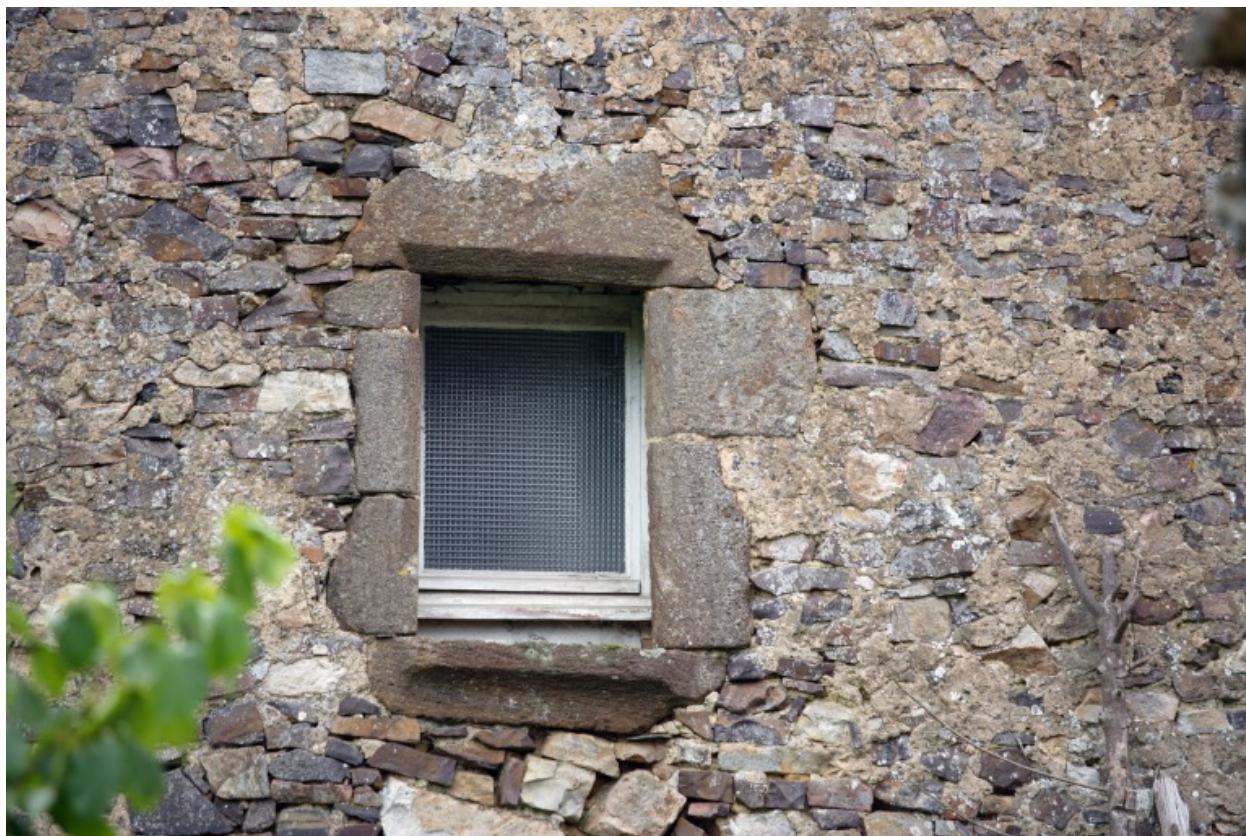
Détail de la façade postérieure : fenêtre.
