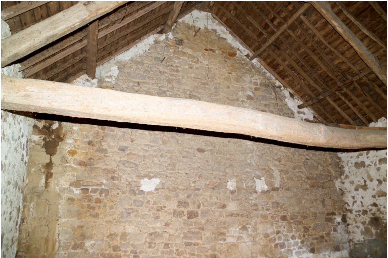
Corps central, portion sud, combles, vue vers le mur sud.
