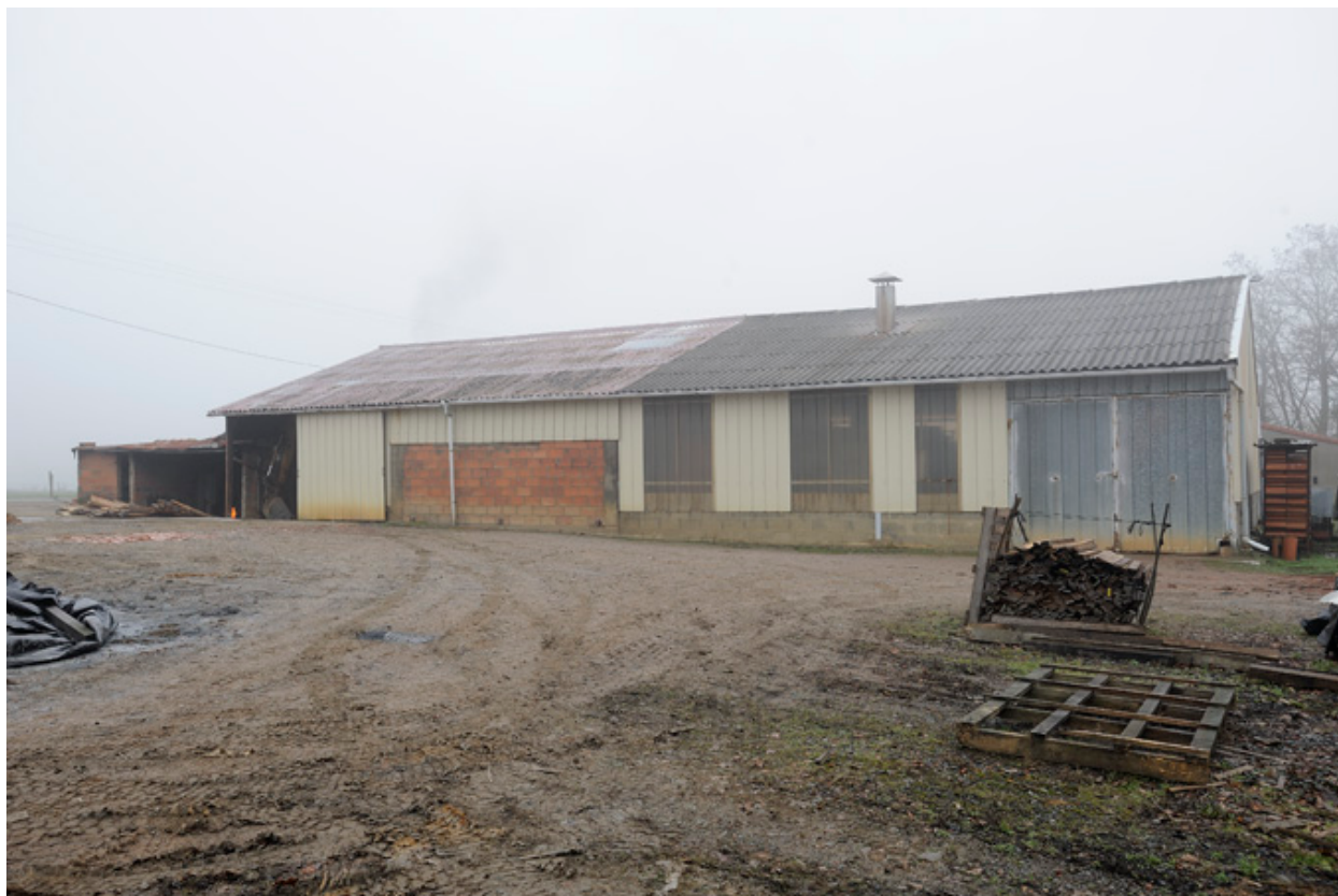
Façade nord-est de la Tuilerie-briqueterie Caillet.
