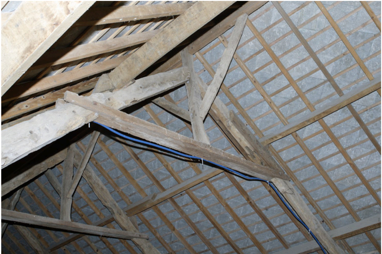
Logis. 3e niveau. Salle est. Détail de la charpente.
