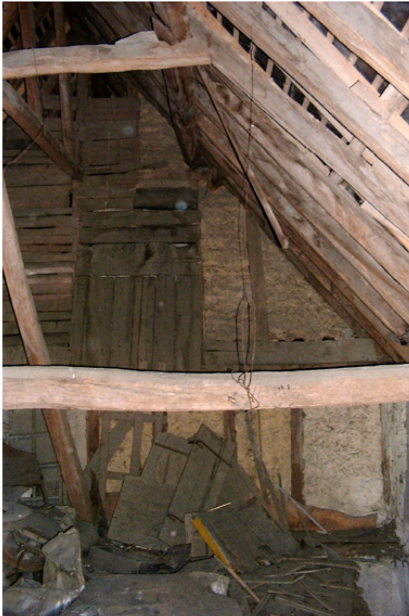
Détail de la charpente.
