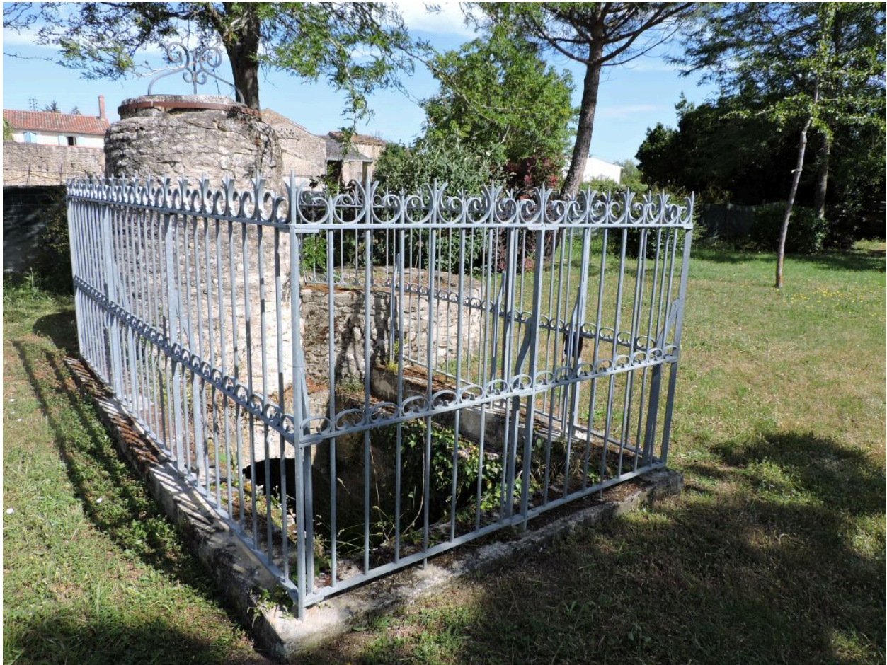
Le puits vu depuis le sud.
