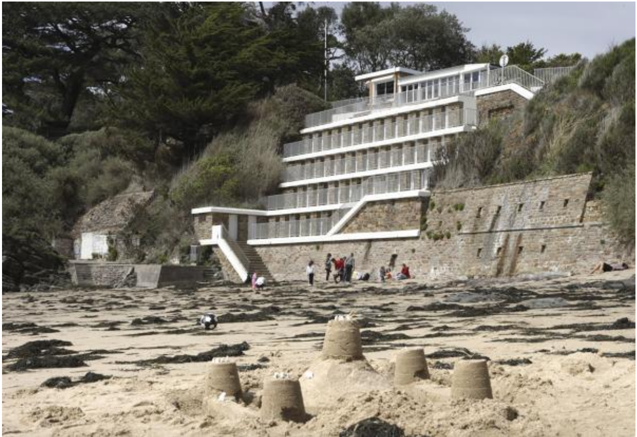
Cabines de bains en maçonnerie de La Birochère.
