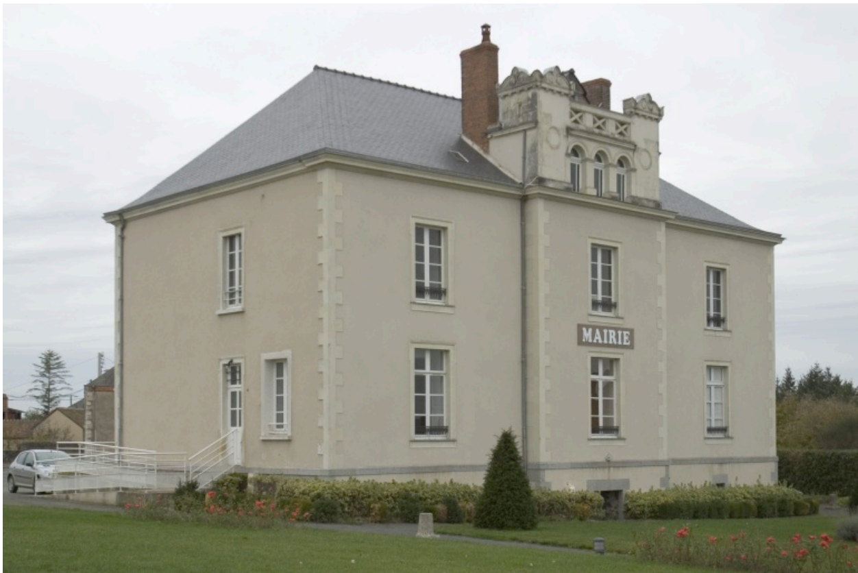
La façade principale, donnant sur la route du Mans.
