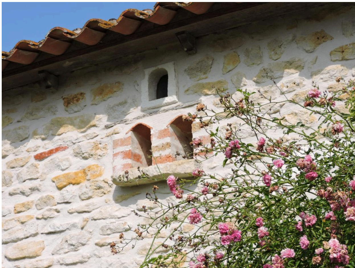
Boulins à pigeons sur la façade du hangar en pierre.
