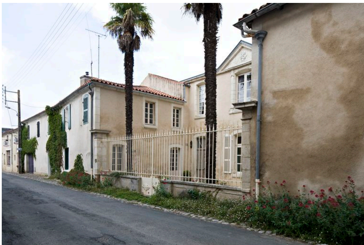
Façade est, donnant sur la rue Alexis-Vinçonneau.
