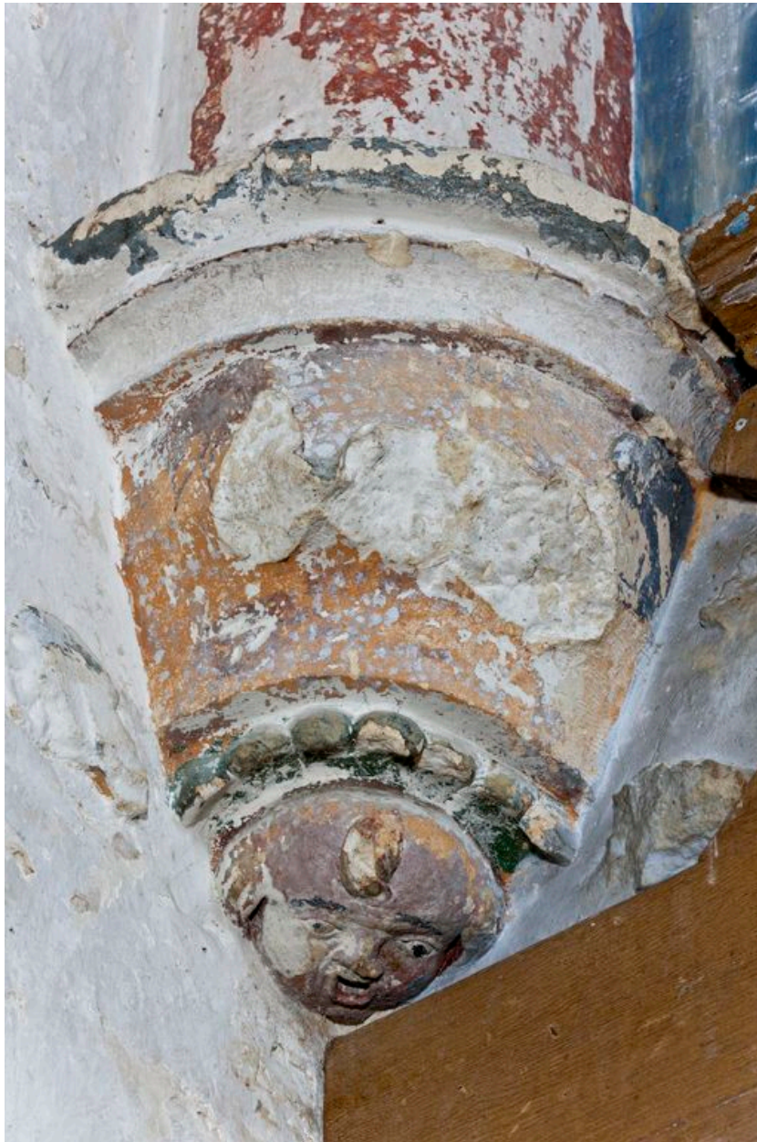
Détail du culot antérieur gauche de la travée II.
