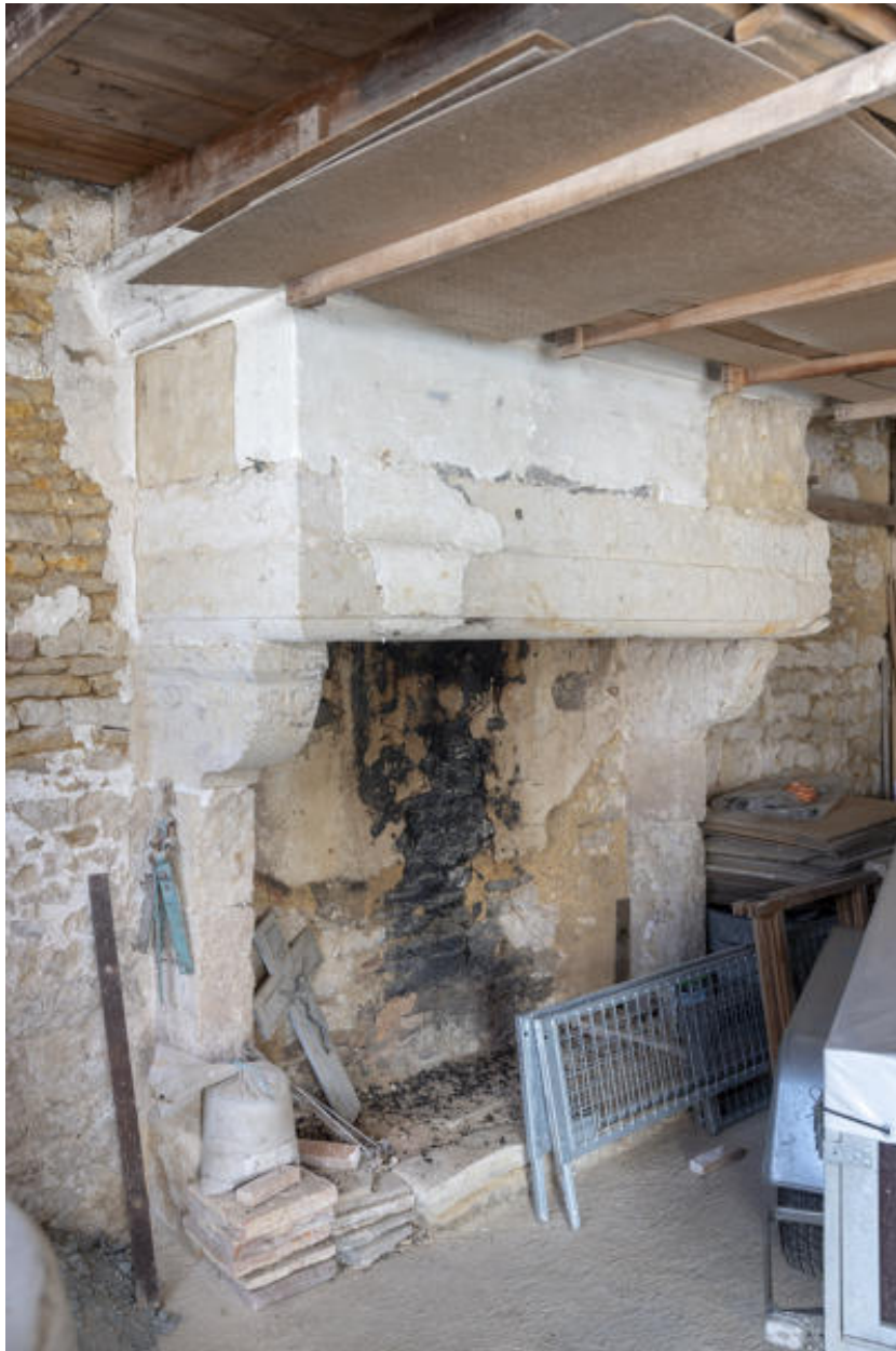
Cheminée dans la remise.
