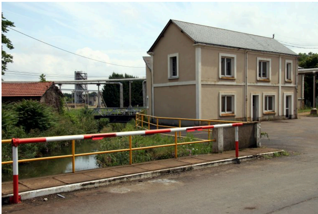
Entrée du site : les bureaux.
