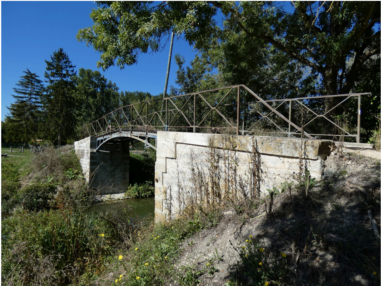
La passerelle vue depuis le sud-est.
