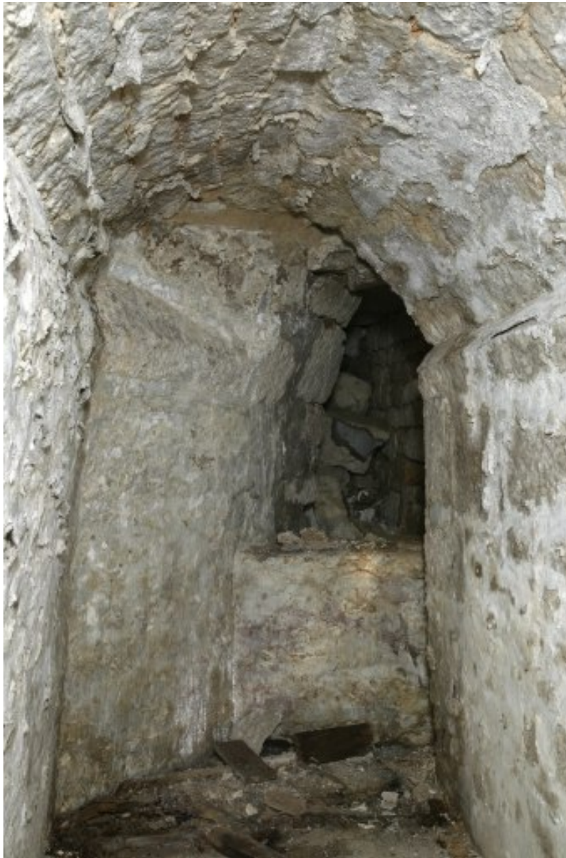
Extrêmité du couloir du sous-sol.
