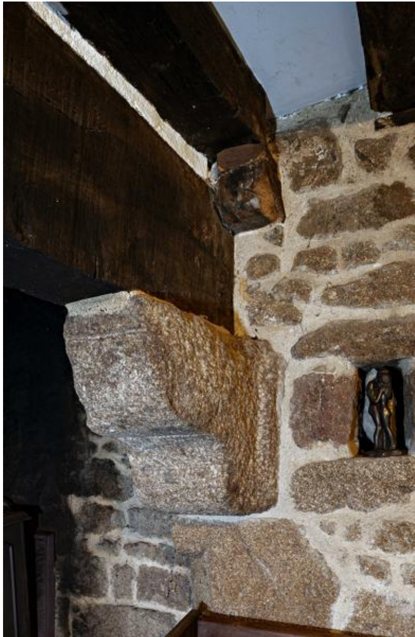
Cheminée de la salle basse, détail du piédroit droit.
