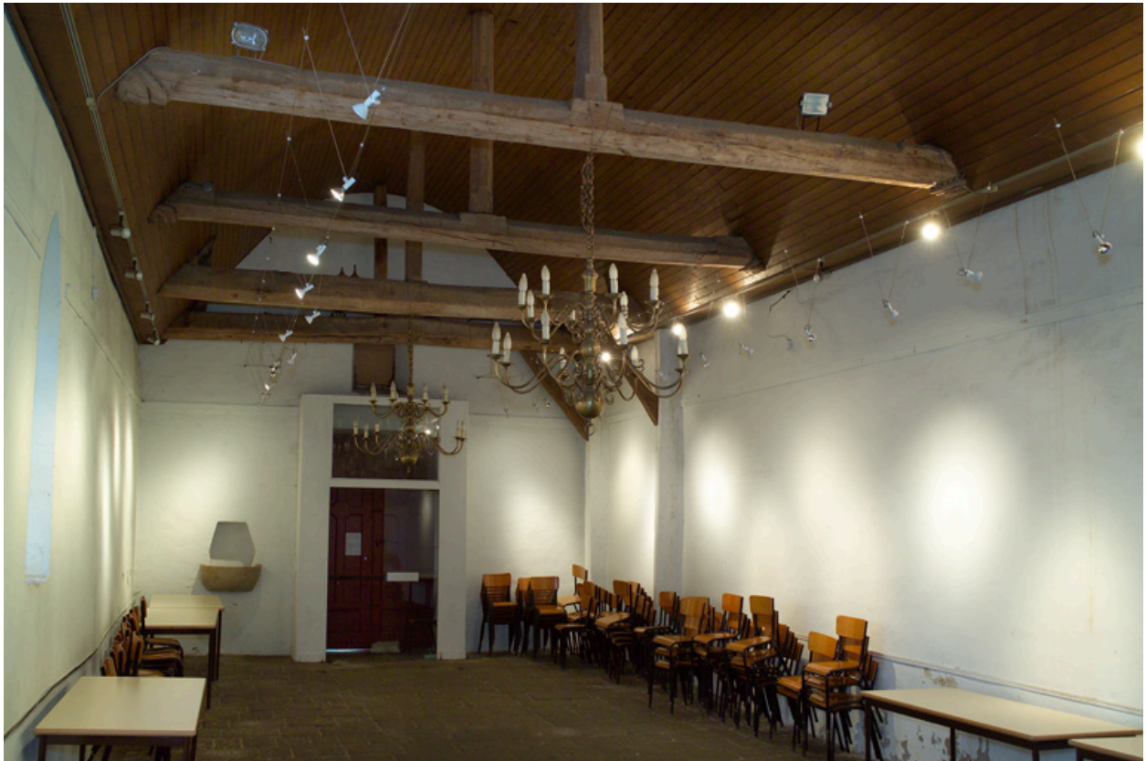
Intérieur de la nef vers le mur ouest.
