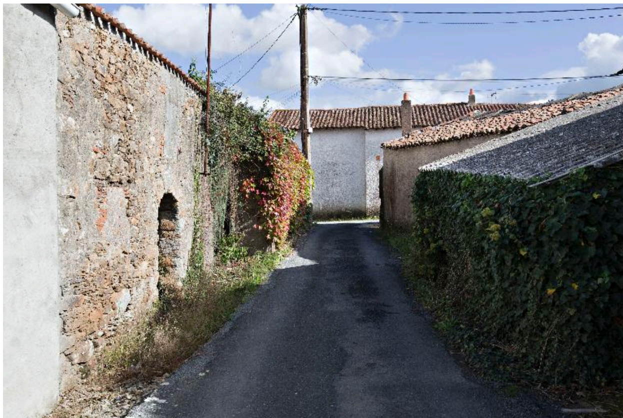
Habitation avec étage de comble de stockage (à gauche de la voie). Vue de la façade principale. La Barillère, Mouzillon, cadastre 2018, AT 02-216.
