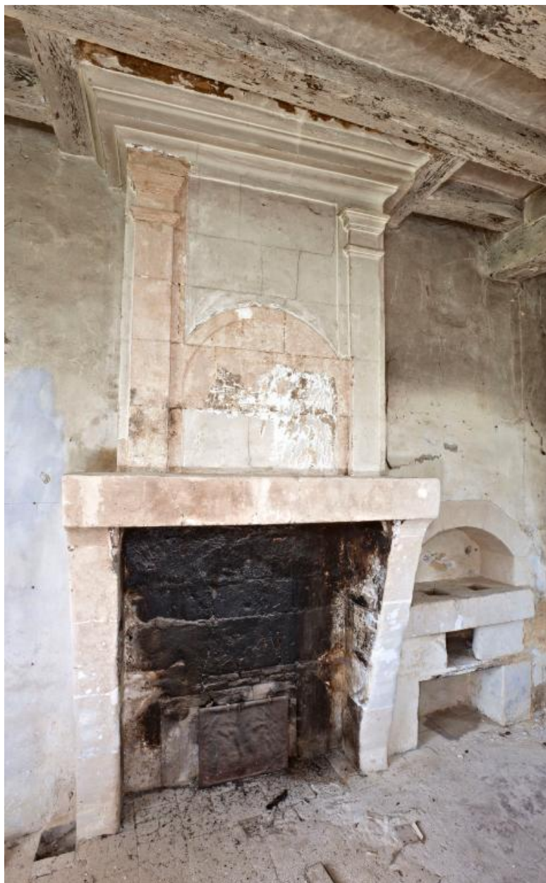
Maison, adjonction nord : cheminée.
