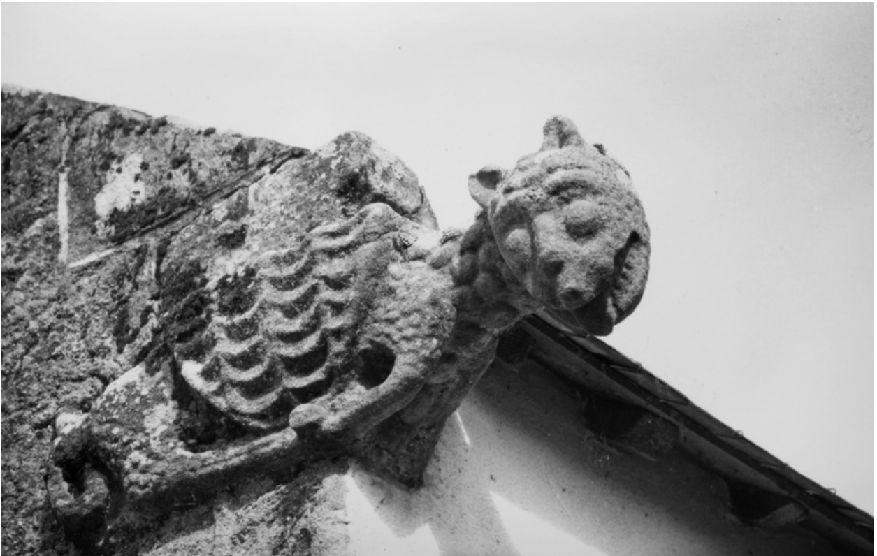
Bâtiment nord, détail d'une acrotère, 1990.
