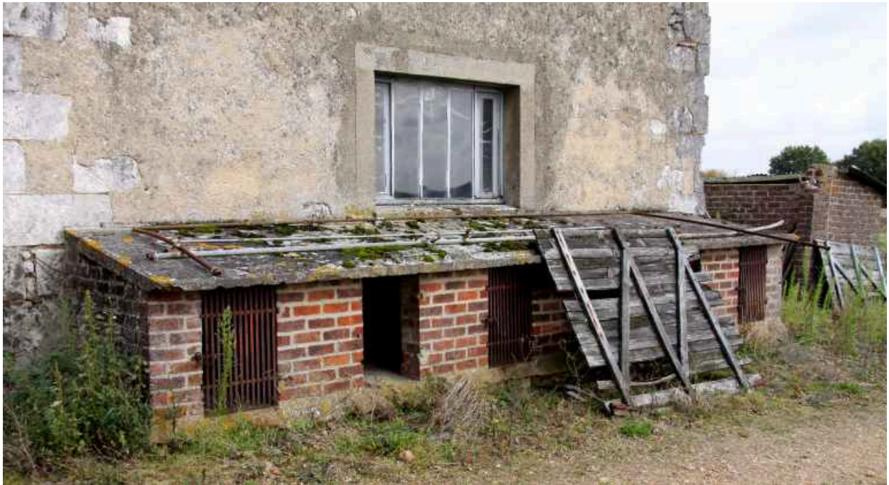
La grange, pignon sud-ouest : clapier à lapins.
