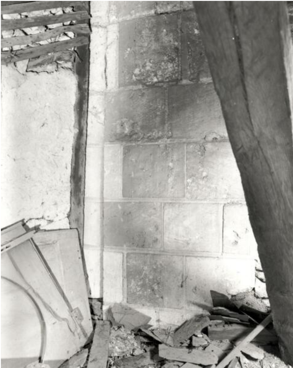
Logis principal 12e s., aile gauche (A1), angle antérieur gauche, premier étage : colonnette d'angle engagée.
