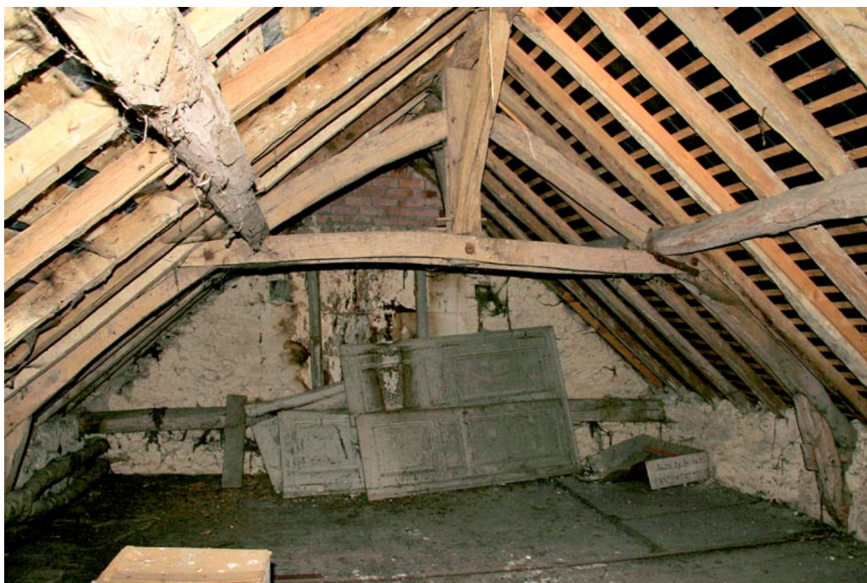
La maison : charpente à pannes.
