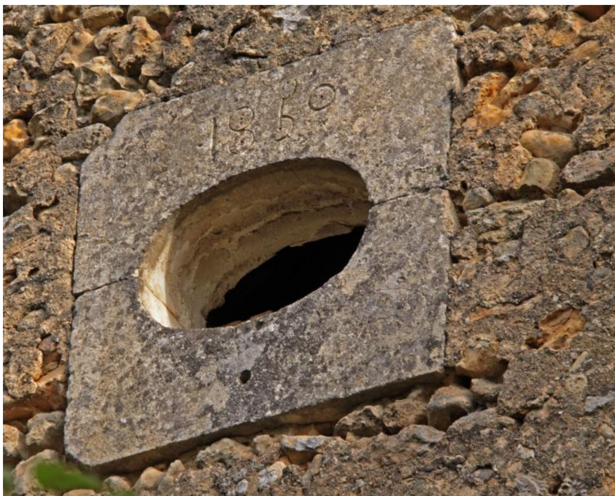
Grange-étable, mur-pignon sud : œil de bœuf portant la date de 1850.
