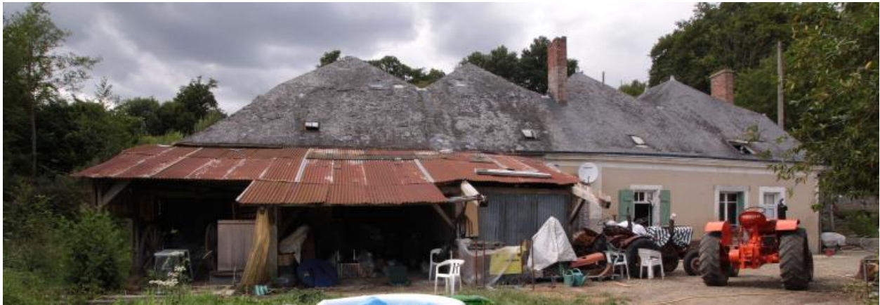
Vue d'ensemble (usine du moulin à gauche).
