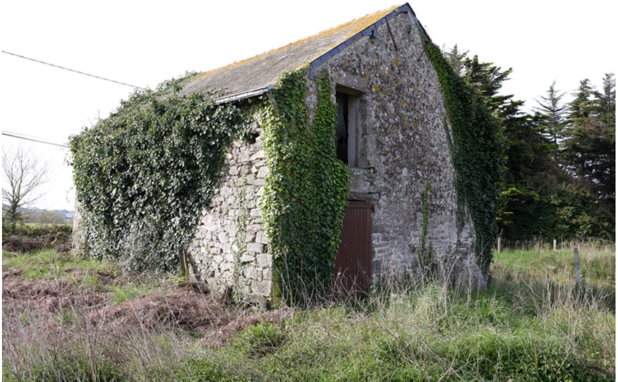
Vue de l'étable sud-est.
