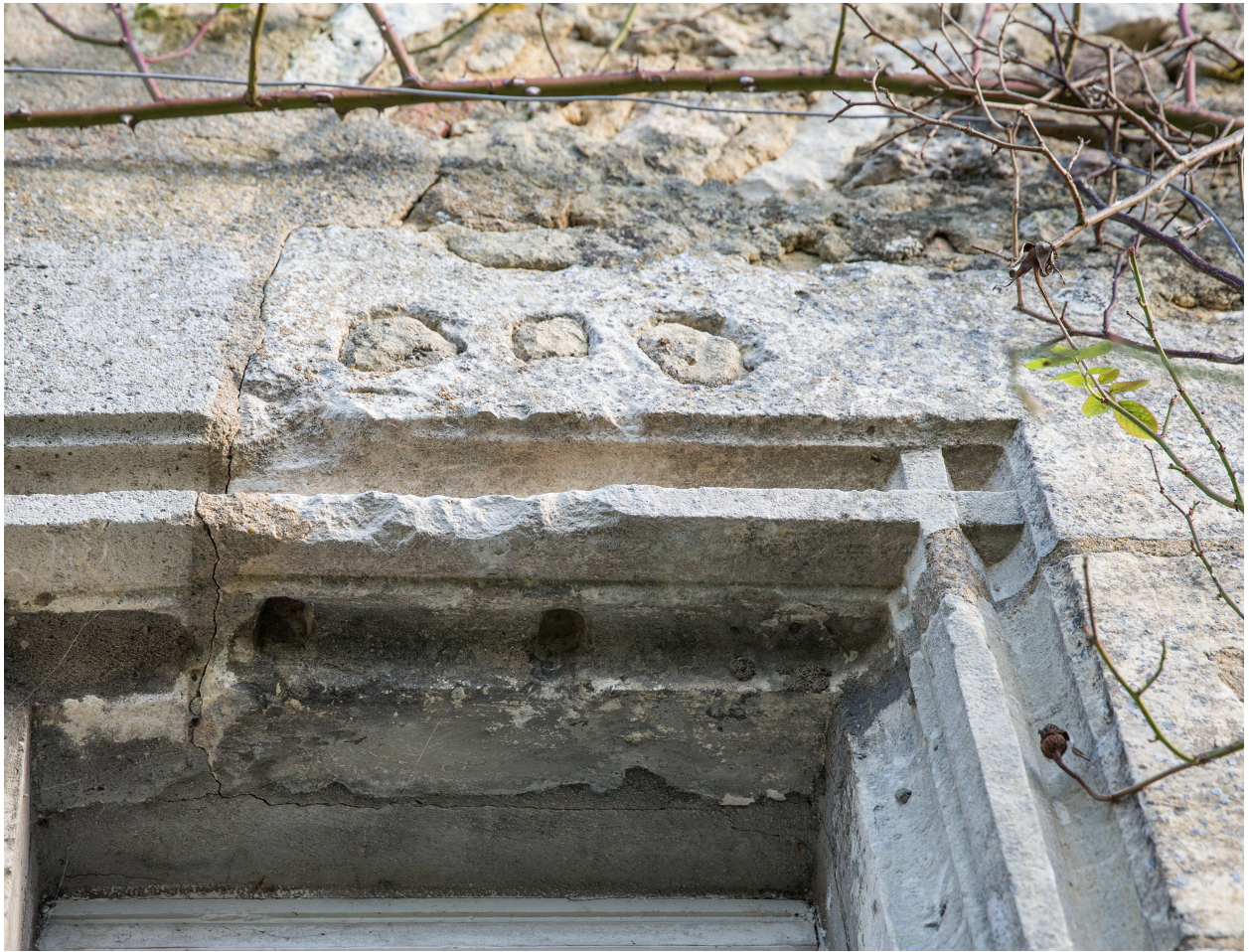
Un détail d'une fenêtre à meneaux du rez-de-chaussée.
