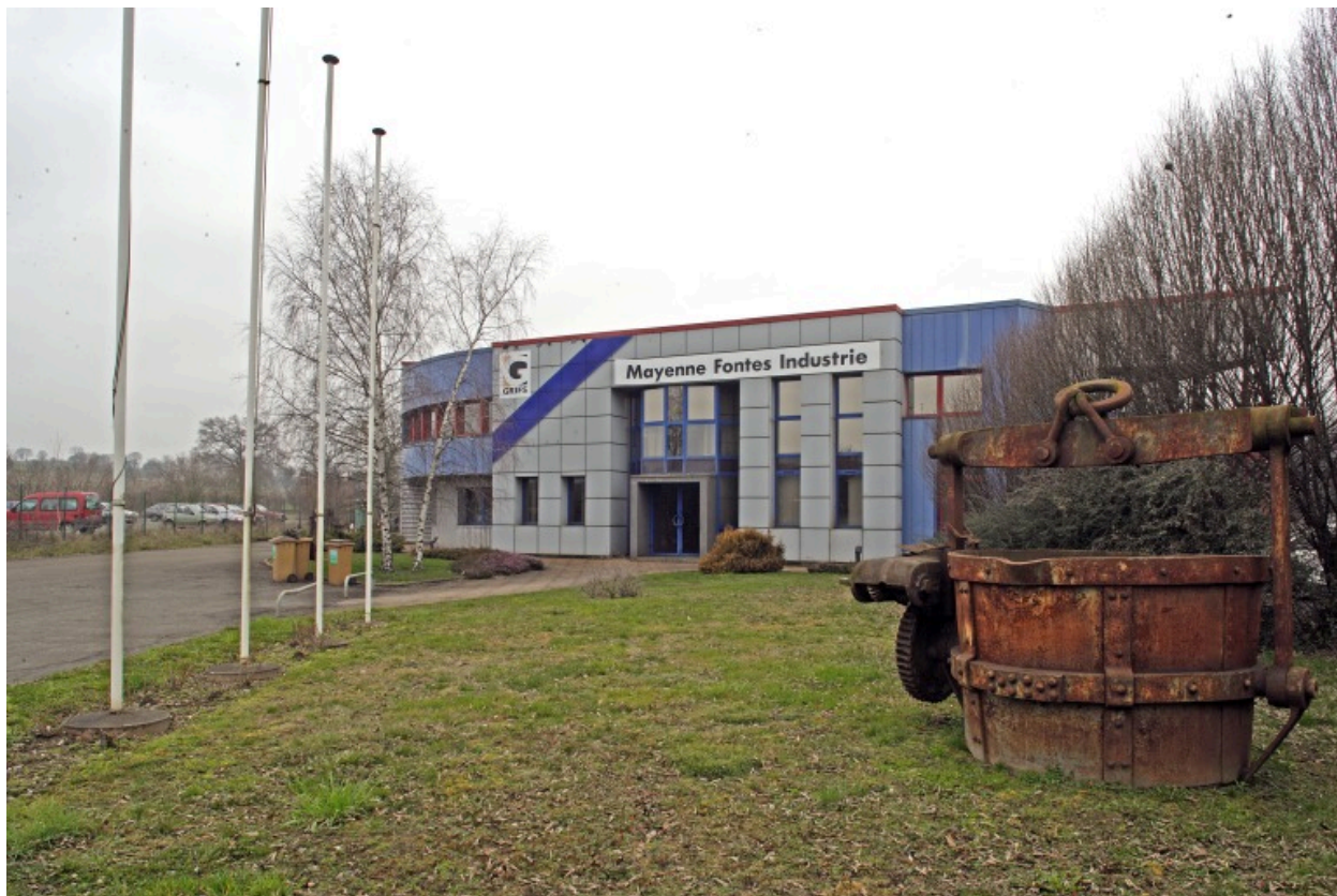
Les bureaux de la fonderie vus depuis le sud. Au premier plan, une poche de coulée.
