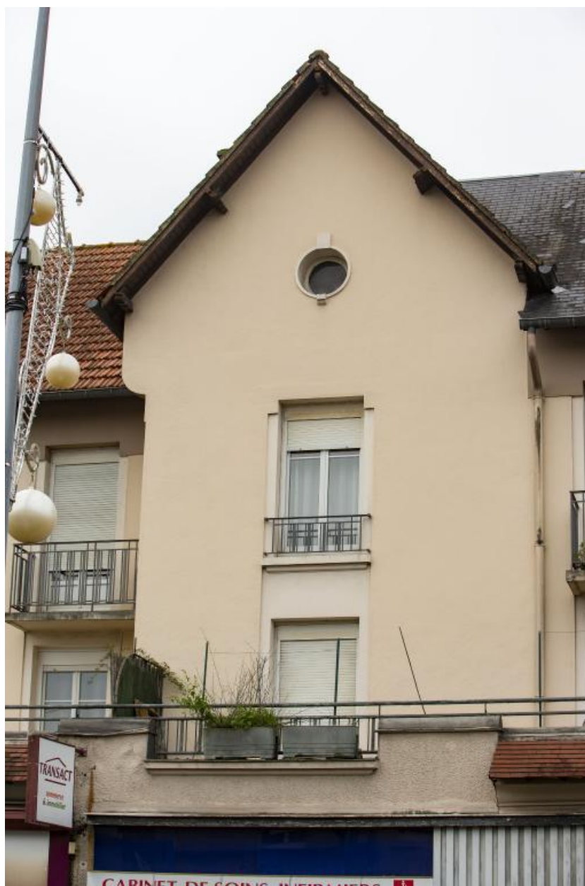
Vue d'une travée pignon sur la façade côté de l'immeuble avenue Felix Geneslay.
