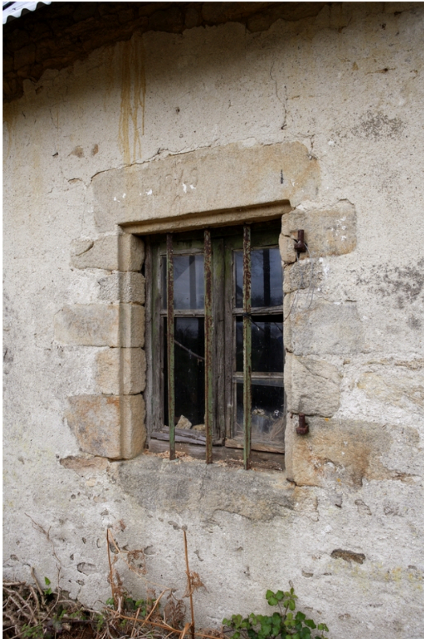
Détail de la fenêtre de la façade principale du 1er logis datée 1849.
