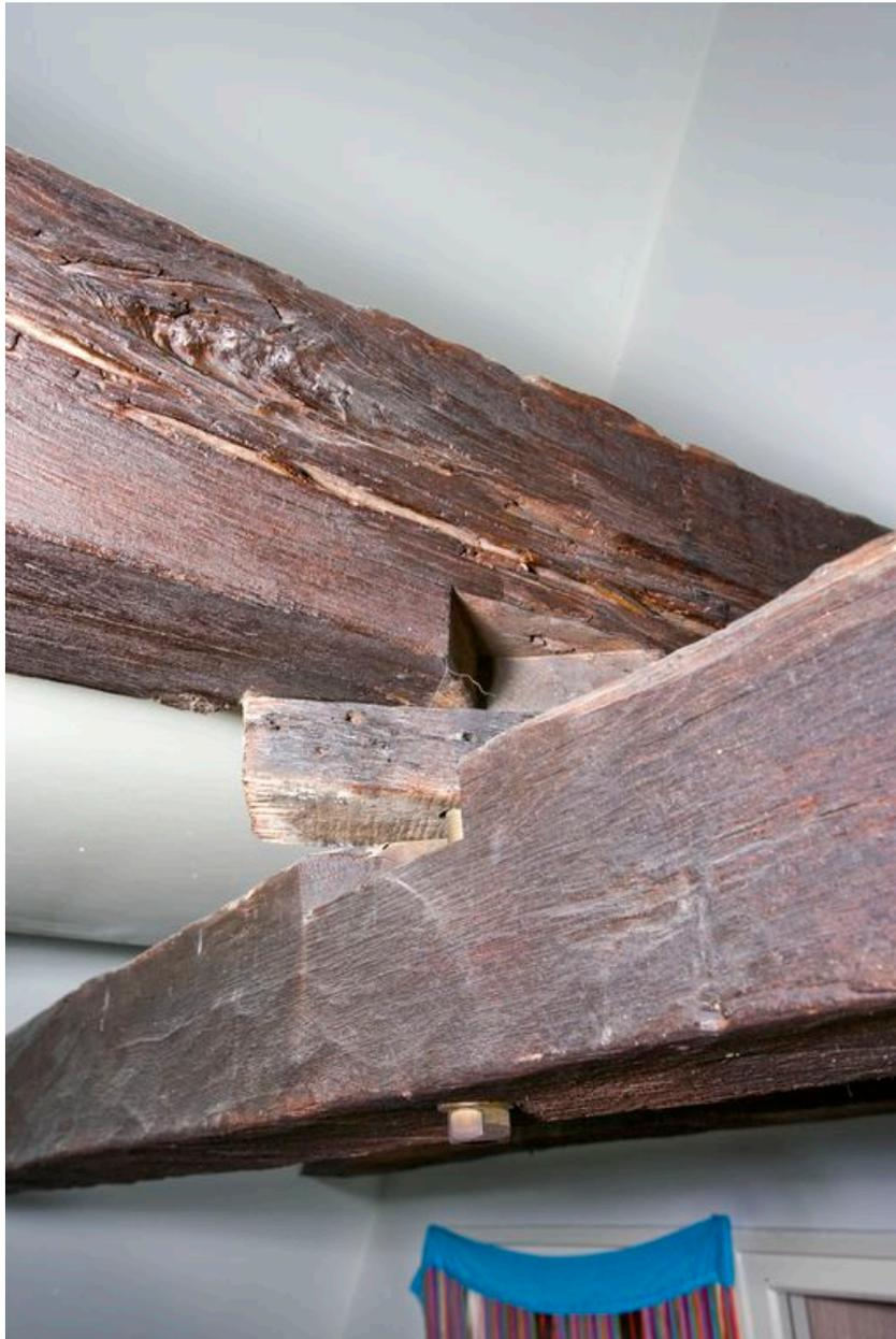
2e étage de comble, charpente : assemblage en queue d'aronde (qui s'est désolidarisé) entre un faux-entrait et une poutre de sous-faîtage ; une cale assure le lien et l'ensemble des pièces est maintenu par une tige filetée.
