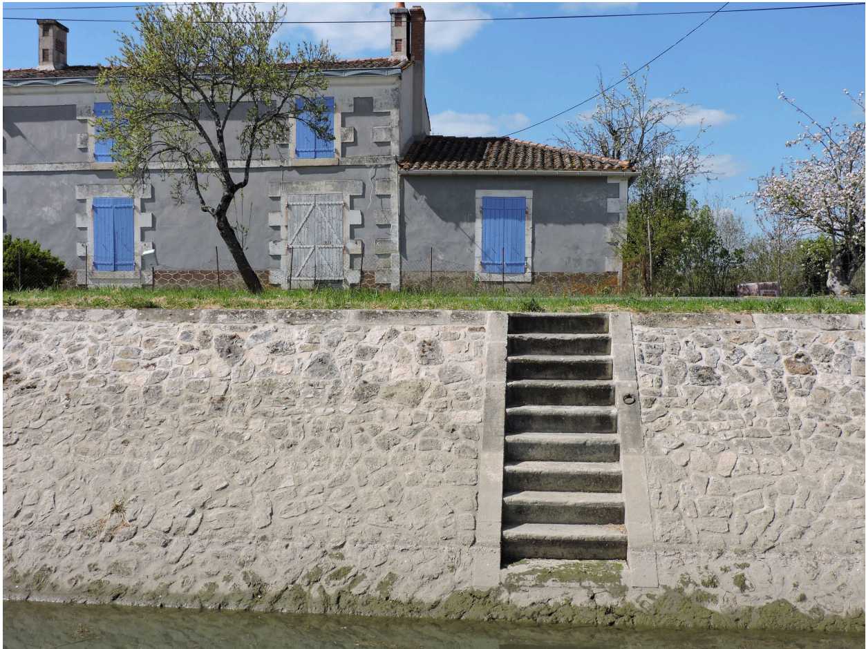
Détail de la maçonnerie et escalier du sas de l'écluse.
