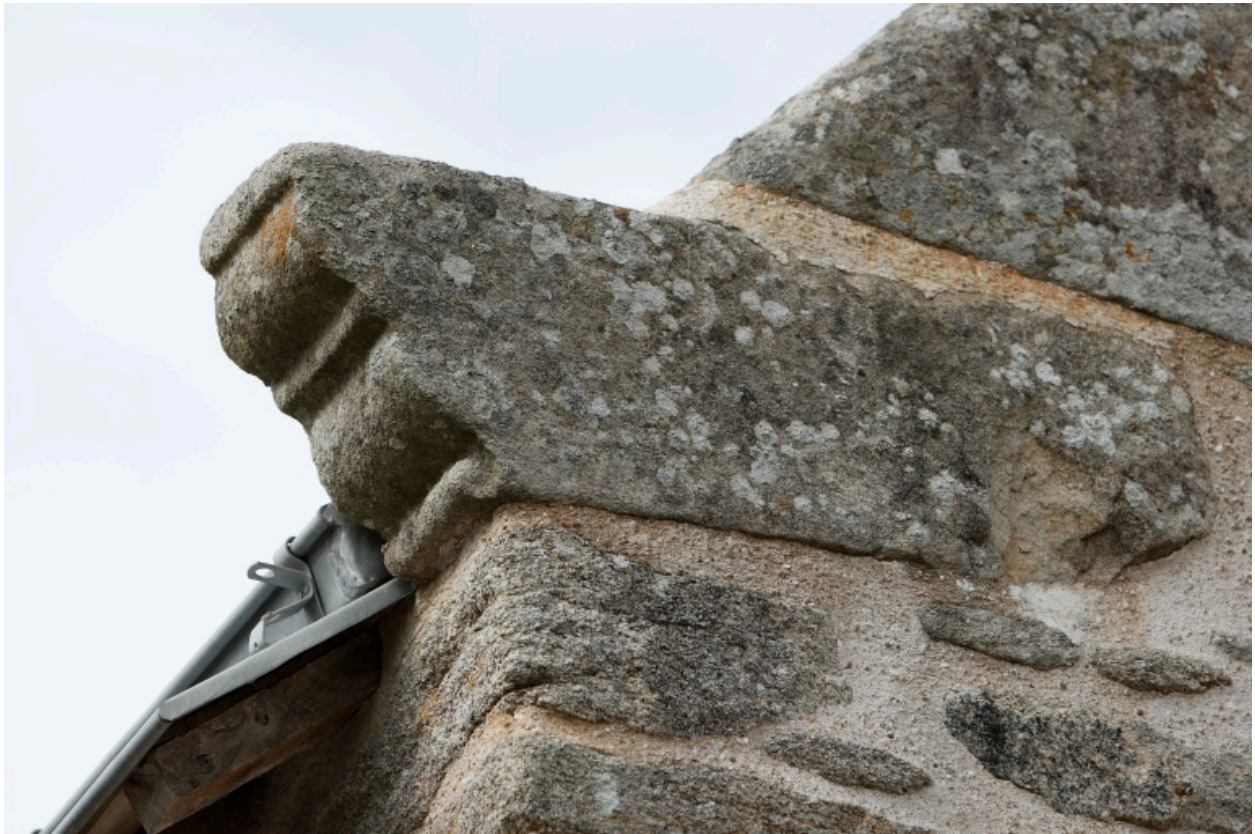
Détail de la crossette à l'angle sud-est.
