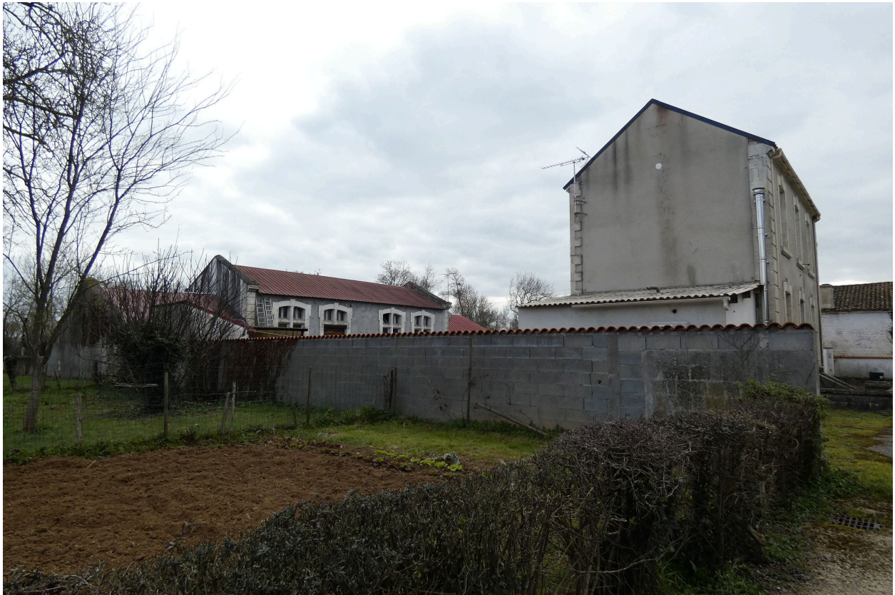
L'ancienne école vue depuis le nord.
