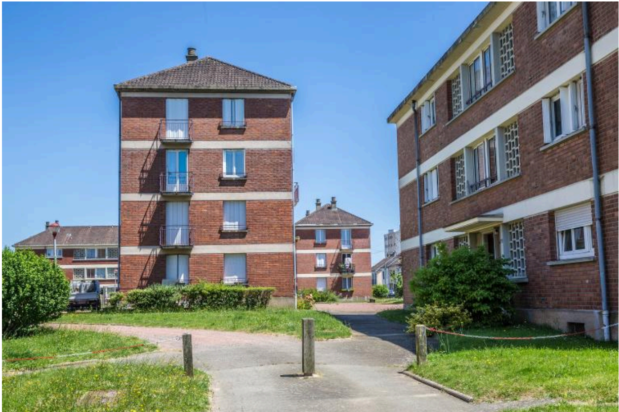
Vue d'ensemble des immeubles de la tranche 1.
