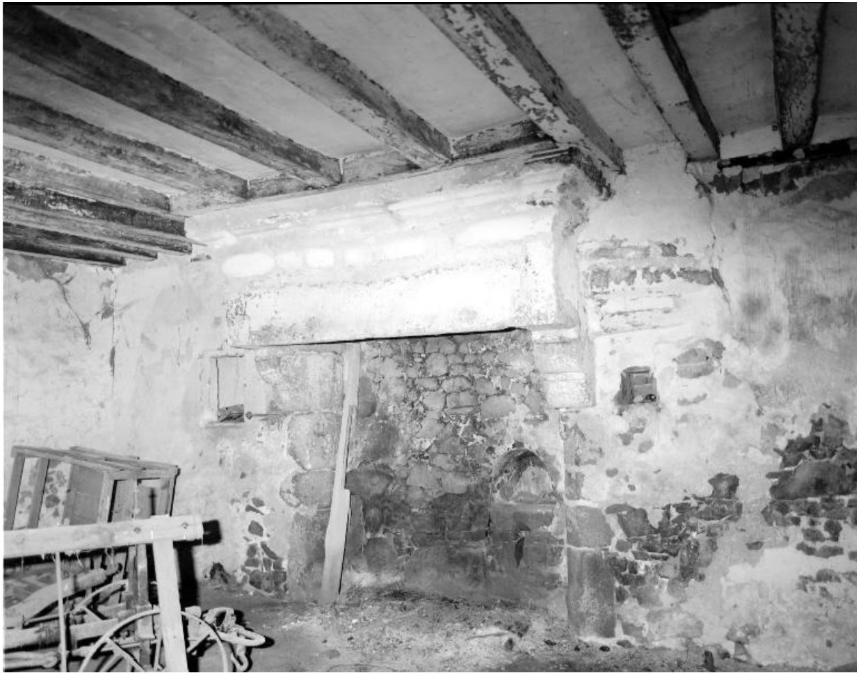
La cheminée du rez-de-chaussée.
