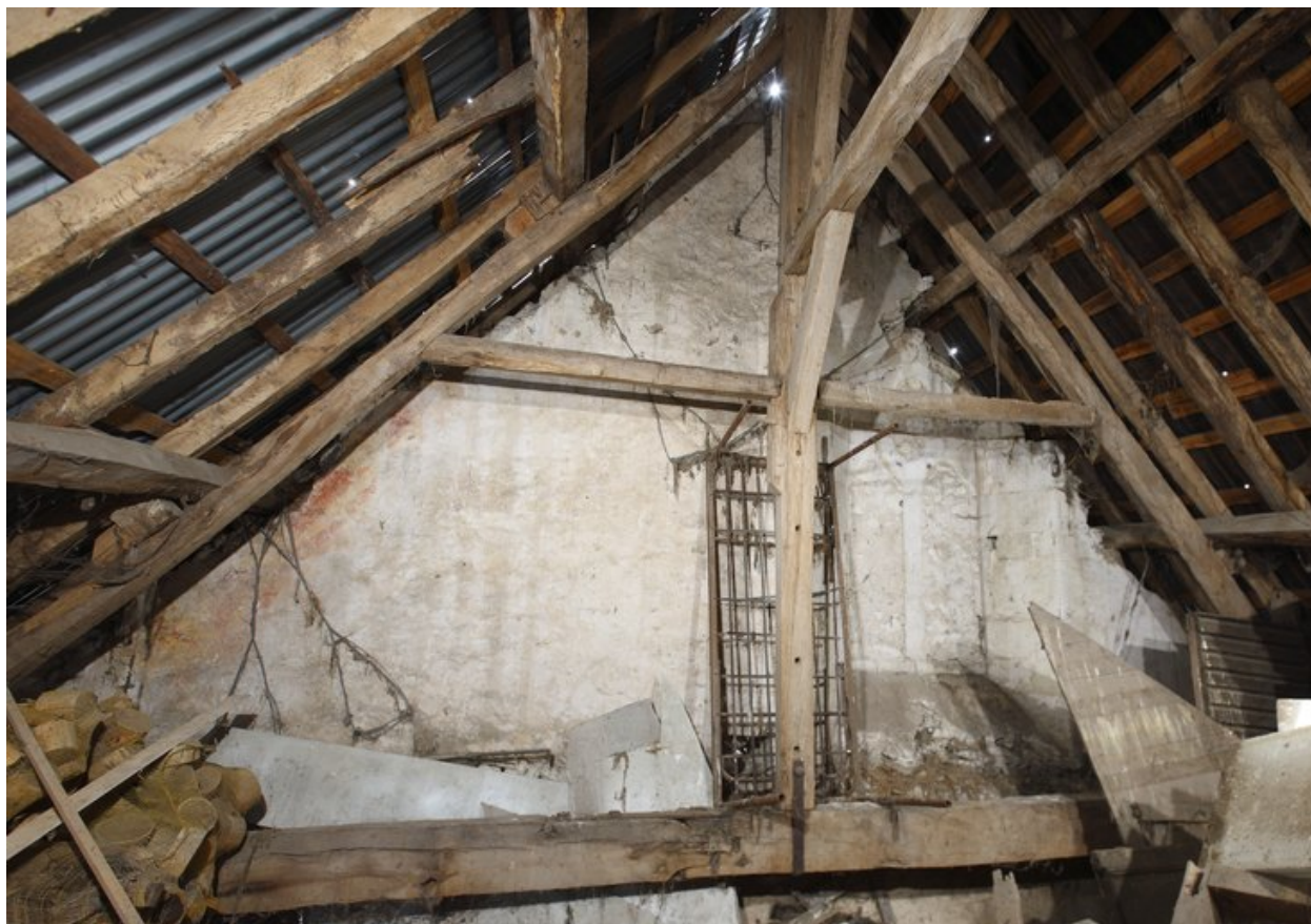
Vue générale du pignon conservant des vestiges de décors peints.
